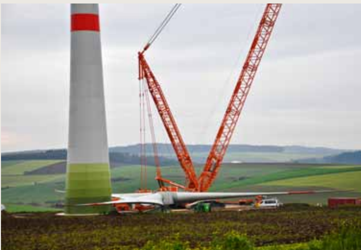
Wie eine Schere liegt der vormontierte Rotor am Windradturm in Nassau.
