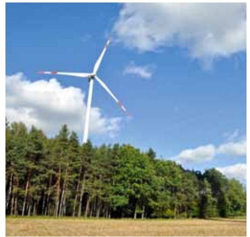
Die Energie ist da: Dieses Windrad ist eine von 16 Anlagen, die juwi auf der Frankenhöhe installiert hat.
